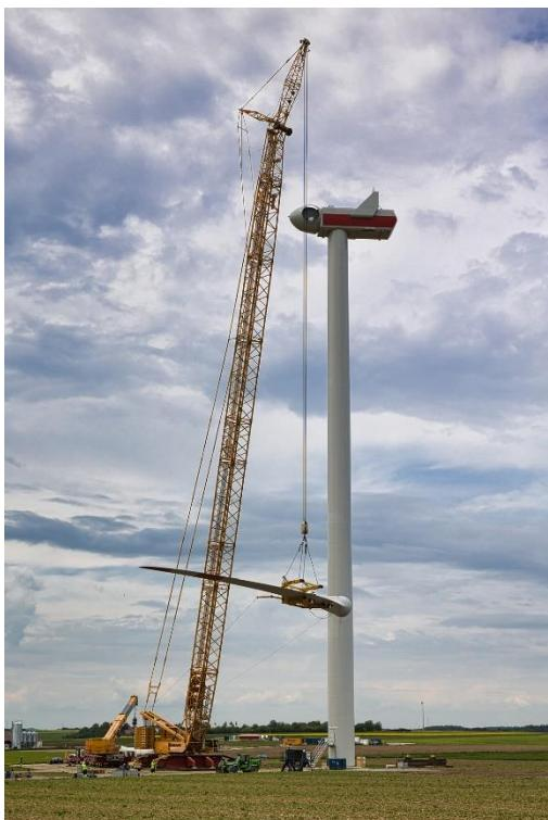
Die beiden Windräder im Freihof haben eine Nabenhöhe von 87 m und können am Standort mit einer Nennleistung von je 3,6 Megawatt emissionsfrei Strom erzeugen. Ihr Strom wird über das Kabel der bereits bestehenden Anlagen ins Umspannwerk in Ellwangen geleitet.
